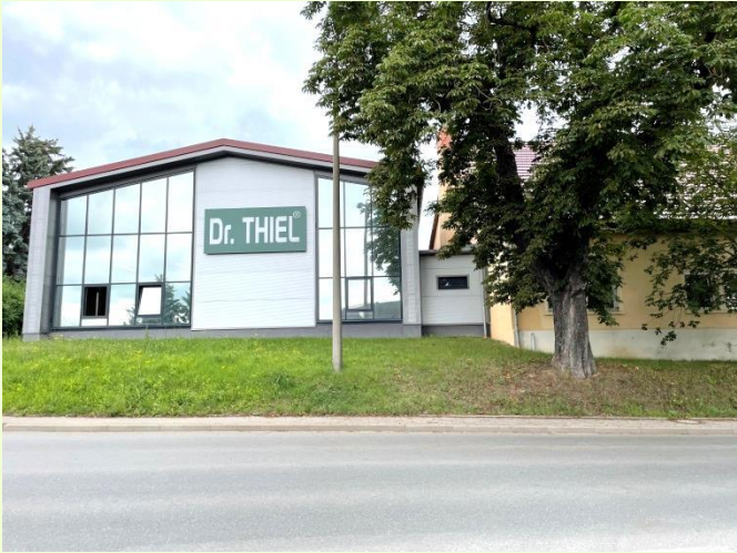
Abb. 244: Vor-Ort-Aufnahmen Sulzaer Str.
