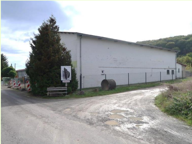
Abb. 357: Vor-Ort-Aufnahmen Innere Erschließung GE "Auenweg"
